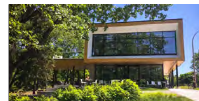
Pavillon d'accueil du Parcours Guin
