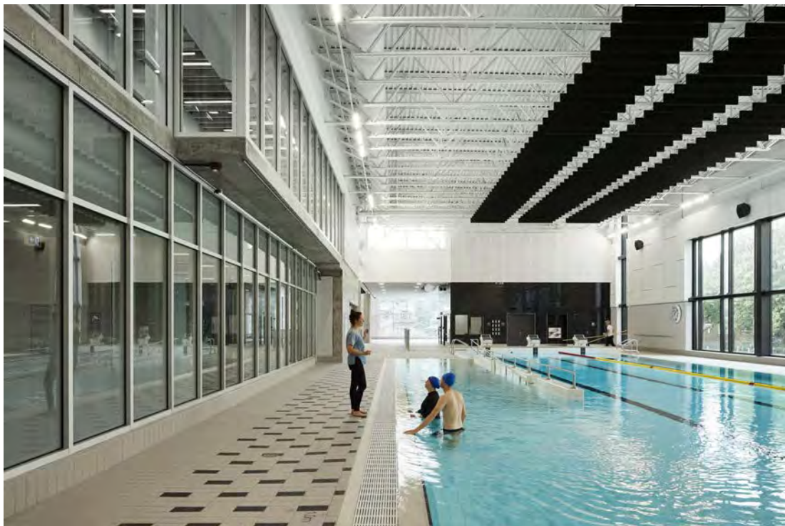
Vue sur le bassin et sa pente accessible ainsi que les vestiaires
