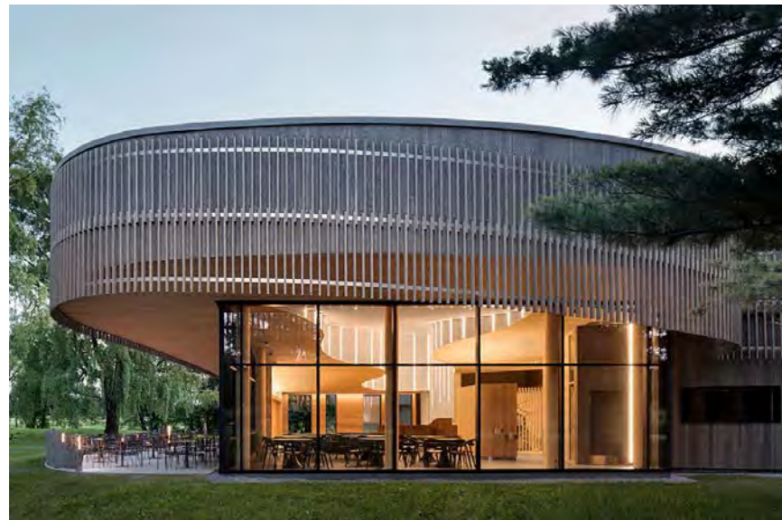
Vue extérieure, arrière de l'espace salle à manger et la terrasse protégée
