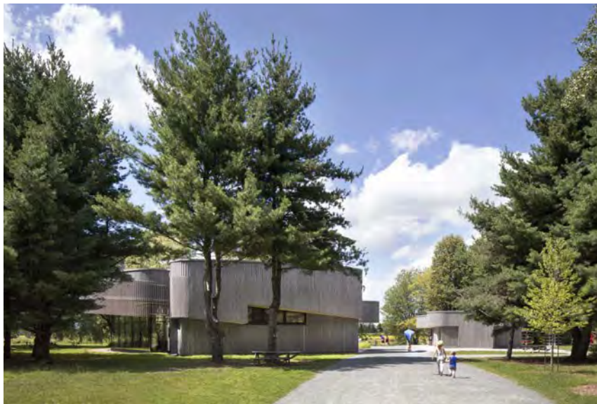
Vue extérieure des deux volumes d'accueil, chemin vers le chenal
